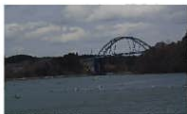
工事が進む大島新橋
